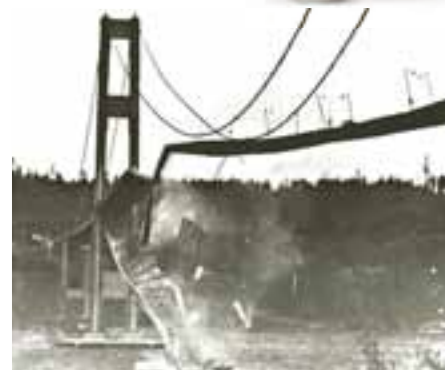
Figura 10. La destrucción del puente Tacoma en Estados Unidos es un ejemplo de un sistema resonante.
